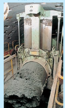
スクリーコンベヤから排出される掘削土砂の状況
