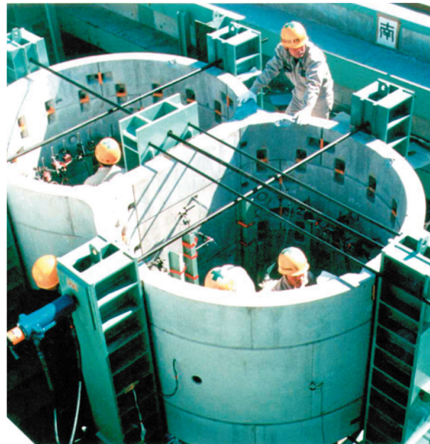
DOTセグメントリング載荷試験
