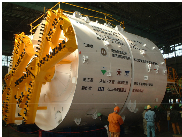
東部丘陵線藤ヶ丘駅東工区建設工事
